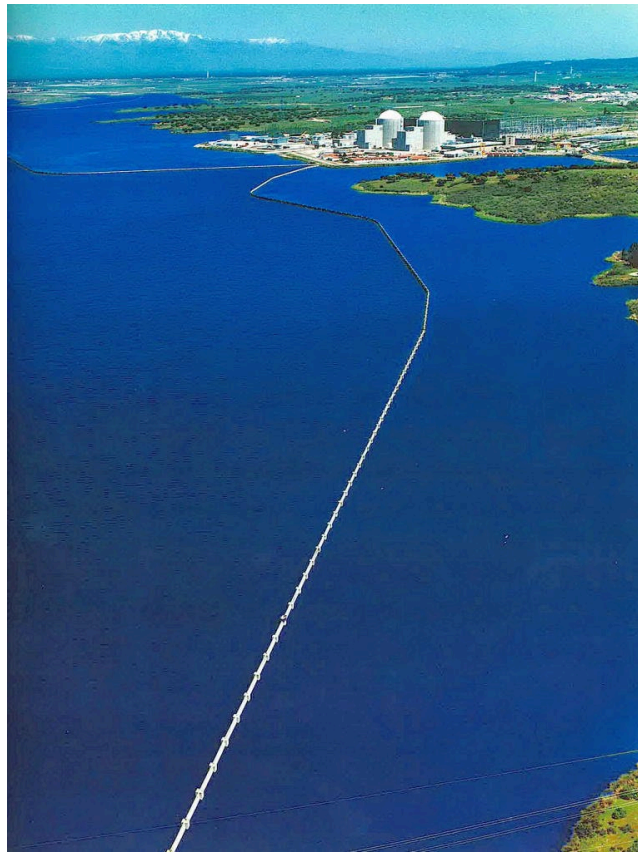
Figura 2. Vista parcial del embalse de Arrocampo desde la zona de la presa. La línea blanquecina del centro es el muro que separa las dos zonas de distintas características térmicas. La central nuclear, en la zona superior derecha, vierte el calor a la porción derecha (en la foto) del embalse y, desde allí, se la fuerza a dirigirse hacia la cola, desde donde regresa hacia la presa por la zona izquierda de la imagen (ved también la Fig. 1). Fuente de la figura: Wikipedia.
